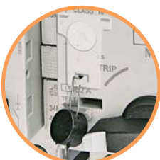
→ Пломбувальна панель регулювання теплового захисту
