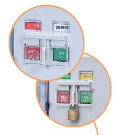
→ Кнопки ручного включения и отключения имеют защитные крышки с возможностью блокировки замком. Выше расположены индикатор "ON-OFF" и индикатор "взвода пружины"
